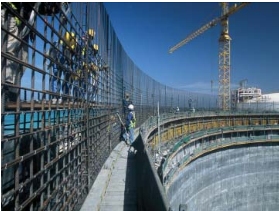
LNG train No. 3, en route to completion.
